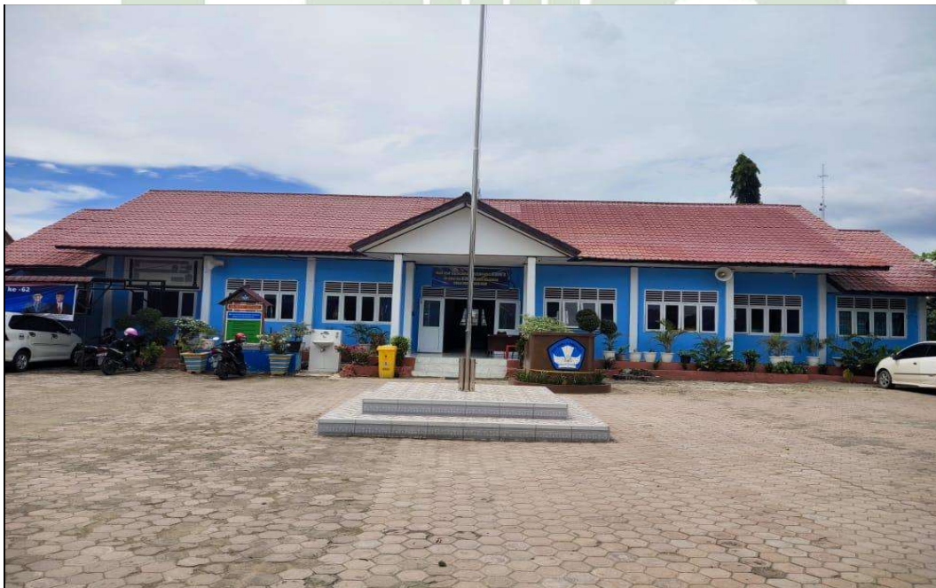
Gambar 6 . Foto gedung sekolah tampak dari depan.
