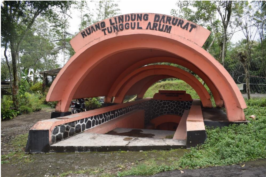
Gambar 3.4. Bunker Darurat di Tunggularum, Lereng Merapi
