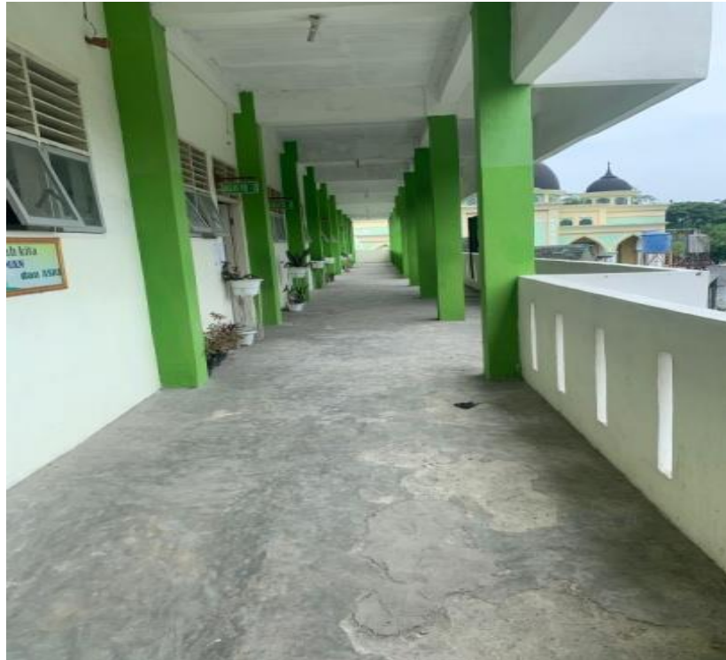
Gambar 9: Ruang kelas Lantai 2 MTs Persiapan Negeri 4
