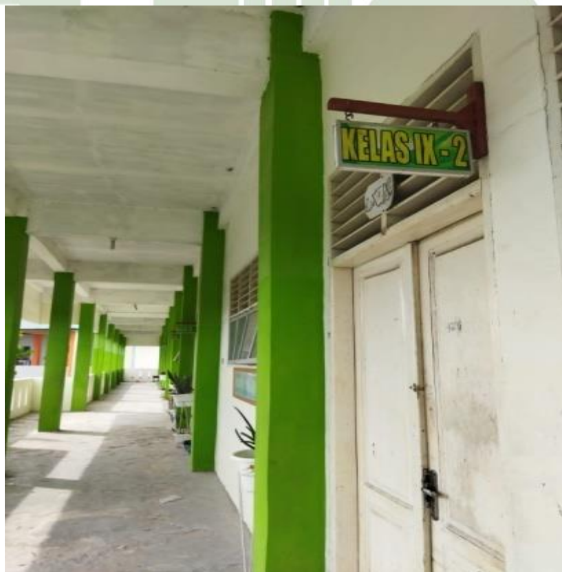
Gambar 9: Ruang kelas Lantai 3 MTs Persiapan Negeri 4
