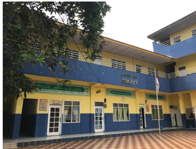
Gambar 7 Bangunan SMP-IT Nurul Hadina
