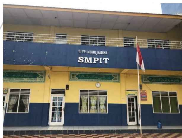
Gambar 6 Bangunan SMP-IT Nurul Hadina
