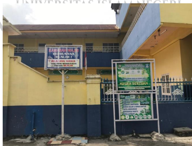
Gambar 9 Bangunan SMP-IT Nurul Hadina
