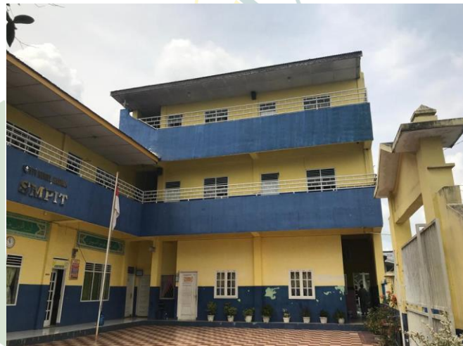
Gambar 8 Bangunan SMP-IT Nurul Hadina
