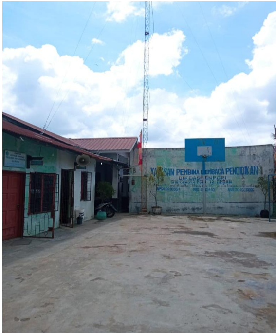
Gambar Gedung Sekolah (Dokumentasi pribadi pada tanggal 28 Juli 2021)
