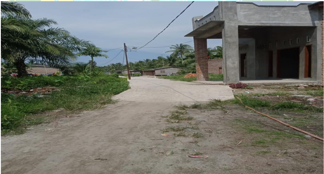
Dokumentasi pembangunan infrastruktur jalan di Gang Tawirja Desa Bandar Sono
