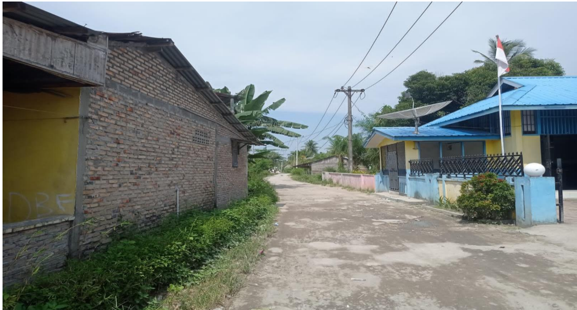
Dokumentasi pembangunan jalan di gang Abdul Majis Desa Bandar Sono
