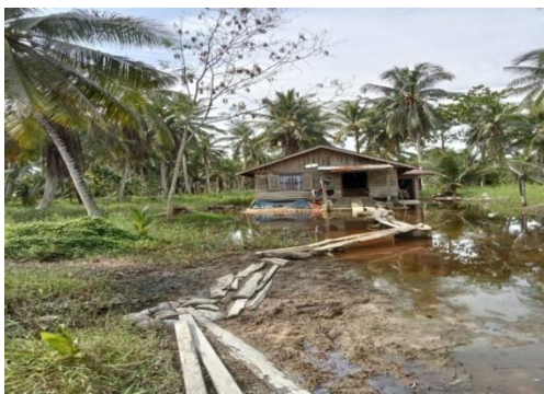
Kondisi Lingkungan Rumah
