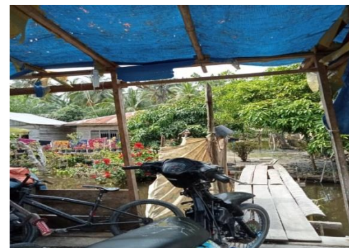
Kondisi Jalan Kerumah
