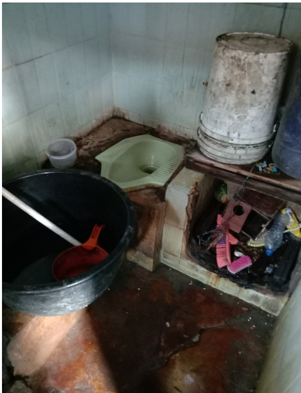
Foto 4 Jamban Responden Di Rumah Susun Sederhana Sewa Amplas Kota Medan
