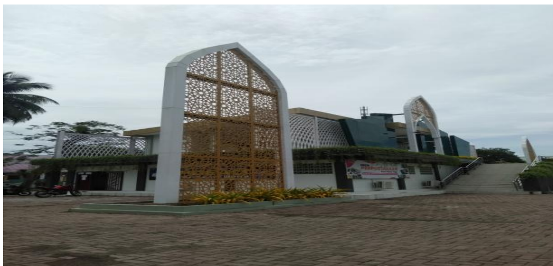
Gambar 1.1 tampak keseluruhan gedung Eks Mimbar Astaka Mtq Kota Tebing-Tinggi
