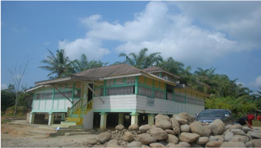
Gambar 1.5 Masjid Raya Ar Rahman sebelum di renovasi
