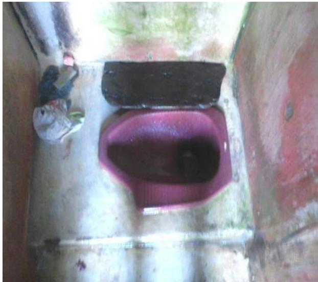
Gambar 11. Salah satu contoh rumah dengan sarana sanitasi dasar berupa jamban yang berlumut dan dinding tidak kedap air
