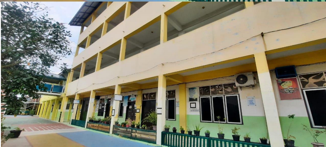
Foto Gedung Kelas SMP Nur Ihsan
