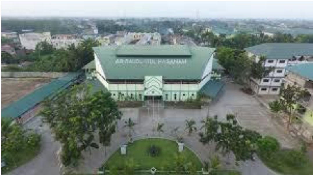
Gedung Asrama Putra
