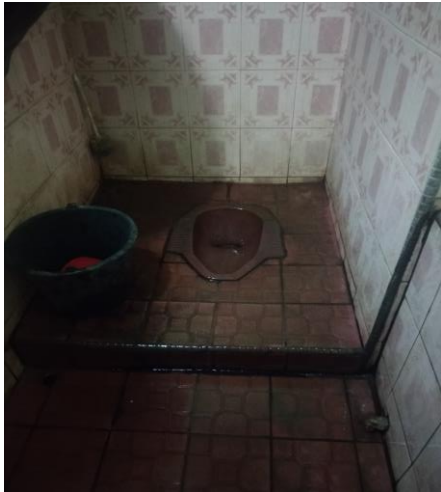
Gambar 5. Jamban leher angsa yang masih tidak bebas dari kecoa dan tidak mudah dibersihkan
