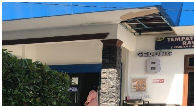
Tidak ada petugas yang mengawasi pasien untuk mencuci tangan
