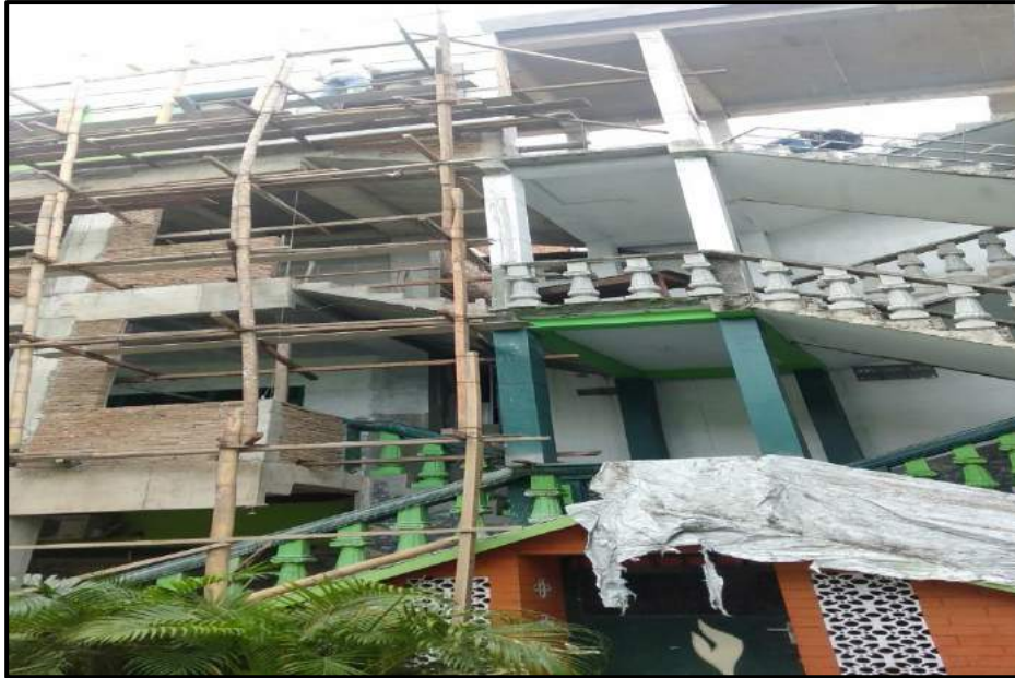
Gambar 11. Rehab Bangunan Madrasah
