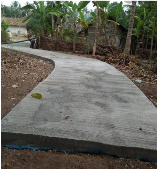
Rambat Beton di Lubuk Rotan III
