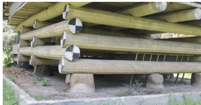
Gambar 14: Galangan induk pada Rumah Bolon Sumber: Buku Sayu Lingga, Rumah Adat Tradisional Simalungun
