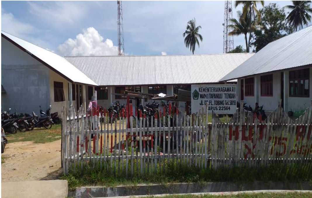
Gambar 3: Bangunan 2 Madrasah Aliyah Negeri 1 Tapanuli Tengah
