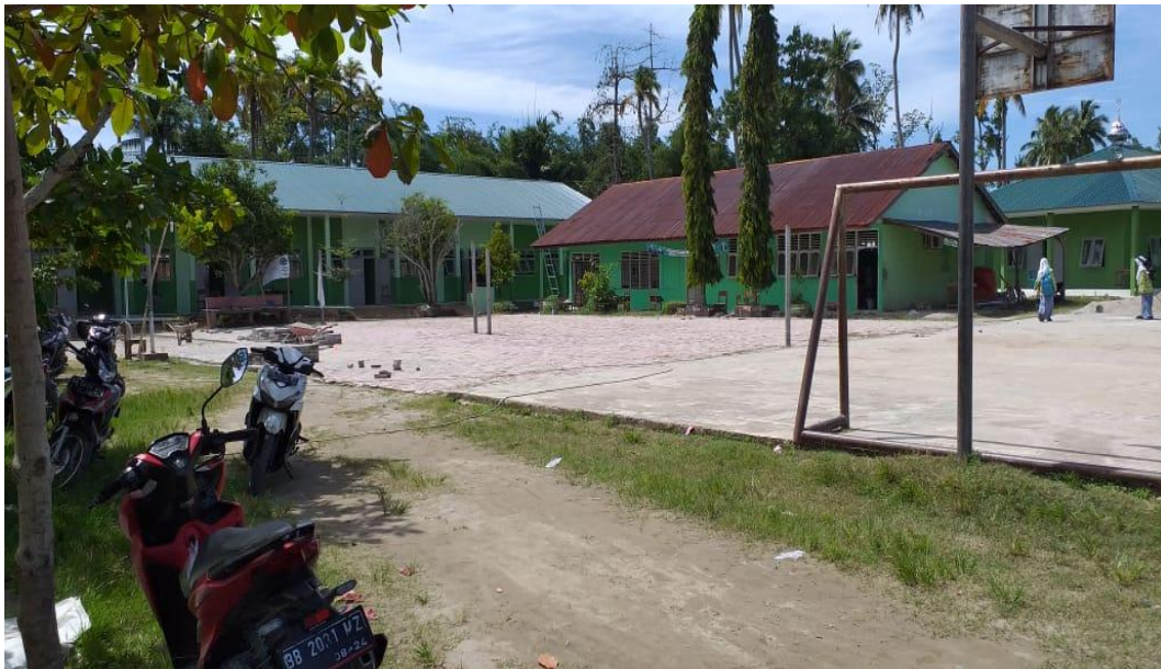
Gambar 2: Bangunan 1 Madrasah Aliyah Negeri 1 Tapanuli Tengah
