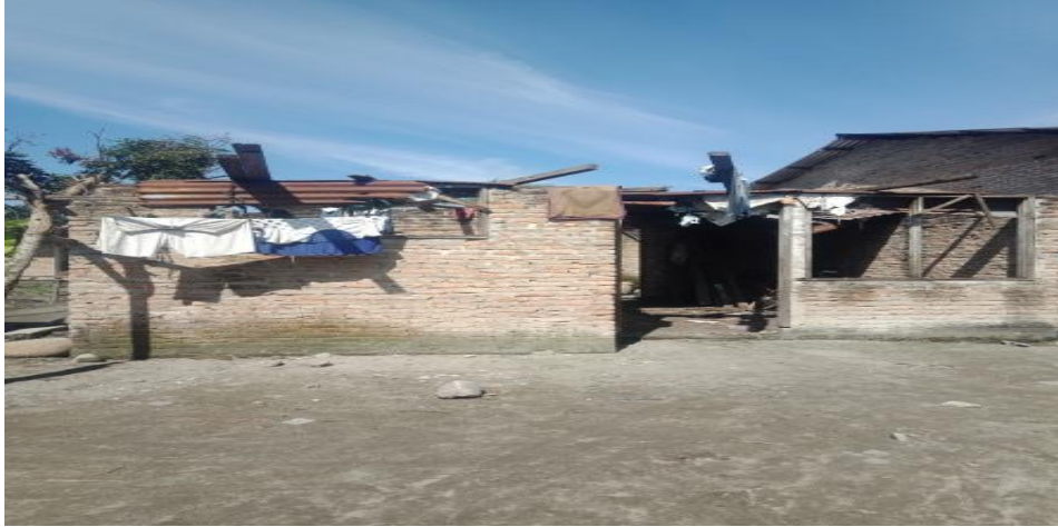
Lampiran 1 Foto rumah sebelum di renovasi
