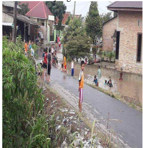
Ket. Banjir akibat drainase yang terbengkalai
