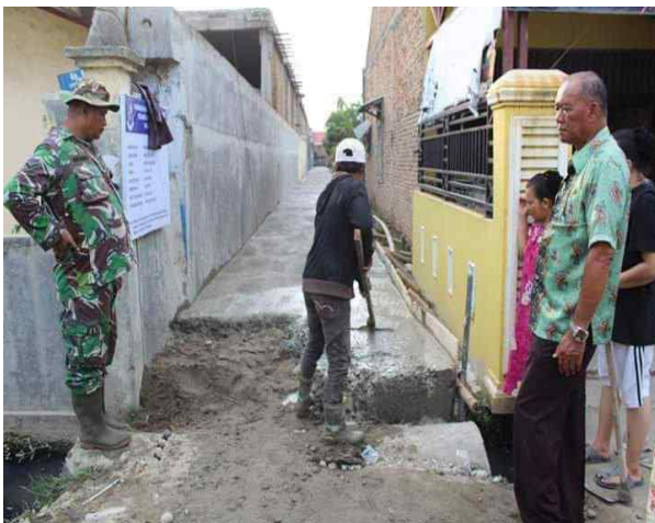
Ket. Pembangunan Jalan
