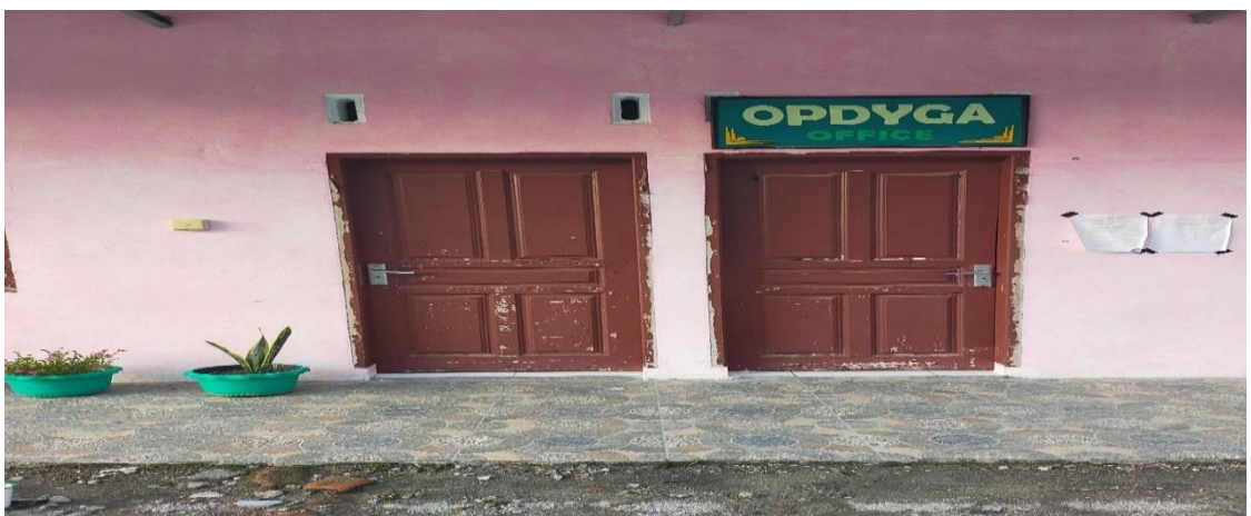
Ruang Bimbingan Konseling (Bagian Depan) Sebelah Kantor OPDYGA ( Gambar 8 )
