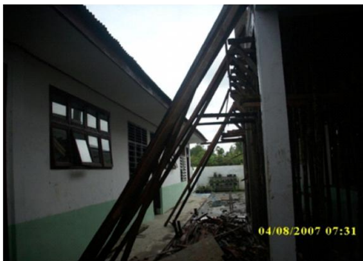
Gambar Ruang kelas yang masih dalam proses pembangunan
