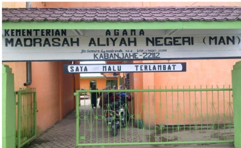
Gambar Pintu masuk gedung MAN Kabanjahe
