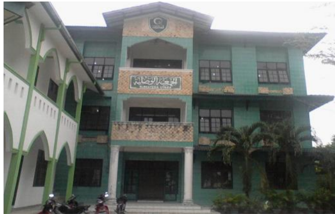
Gambar Gedung Pimpinan Al Washliyah Sumatera
