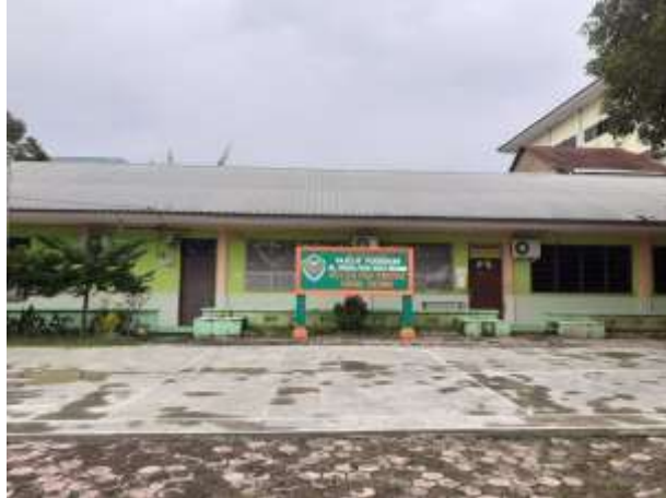
Gambar 1. Gedung halaman depan MTs Ex PGA Proyek Univa Medan
