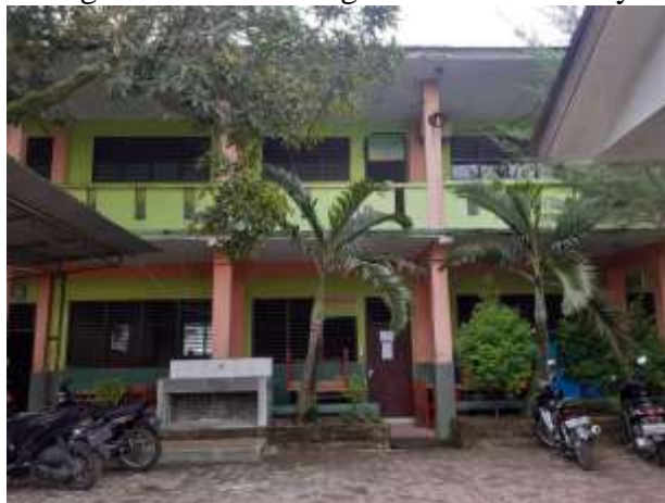
Gambar 2. Gedung halaman belakang MTs Ex PGA Proyek Univa Medan
