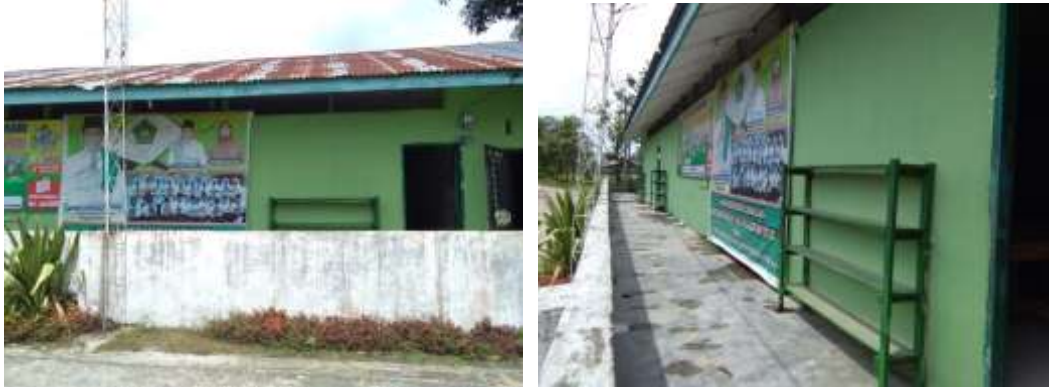
Tampak dari depan Madrasah Tsanawiyah Al Washliyah Wonosari Pantai Cermin
