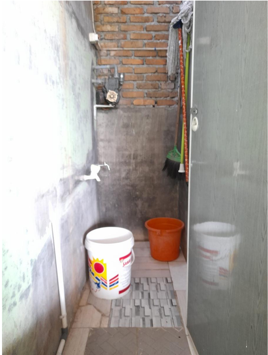
Gambar 4 Kondisi toilet laki-laki
