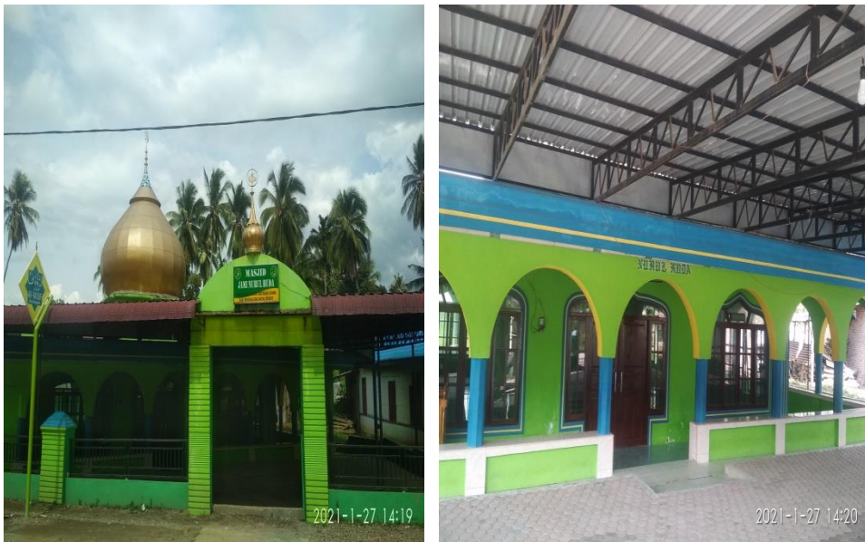
Gambar 16: Foto masjid setelah dilakukan renovasi
