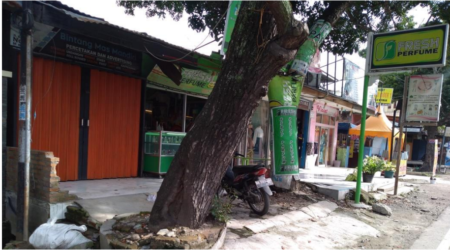
Bangunan di Atas Drainase Jl. Alfalah, Kecamatan Medan Timur, Kota Medan
