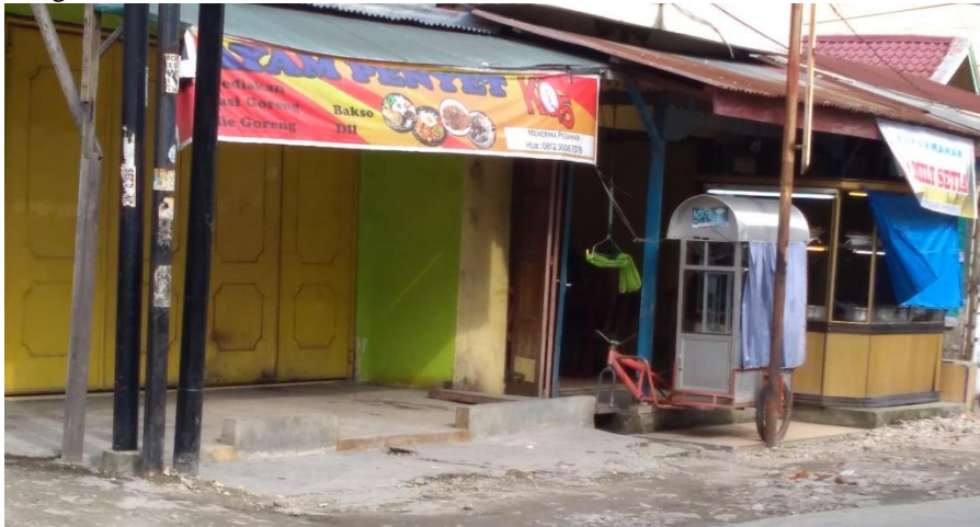
Bangunan di Atas Drainase Jl. Mustafa, Kecamatan Medan Timur, Kota Medan.
