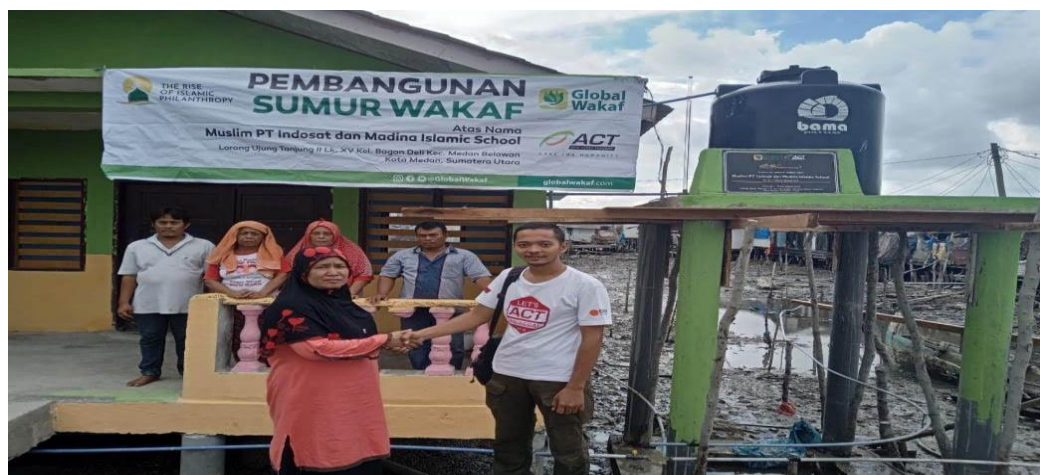
Gambar Pembangunan Sumur Wakaf di Kecamatan Medan Belawan tepatnya di Kampung Nelayan Seberang.
