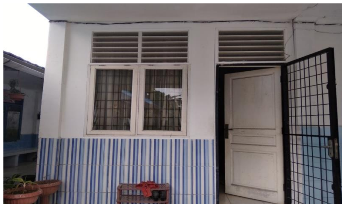
Gambar Ruang BK SMP Negeri 5 Percut Sei Tuan
