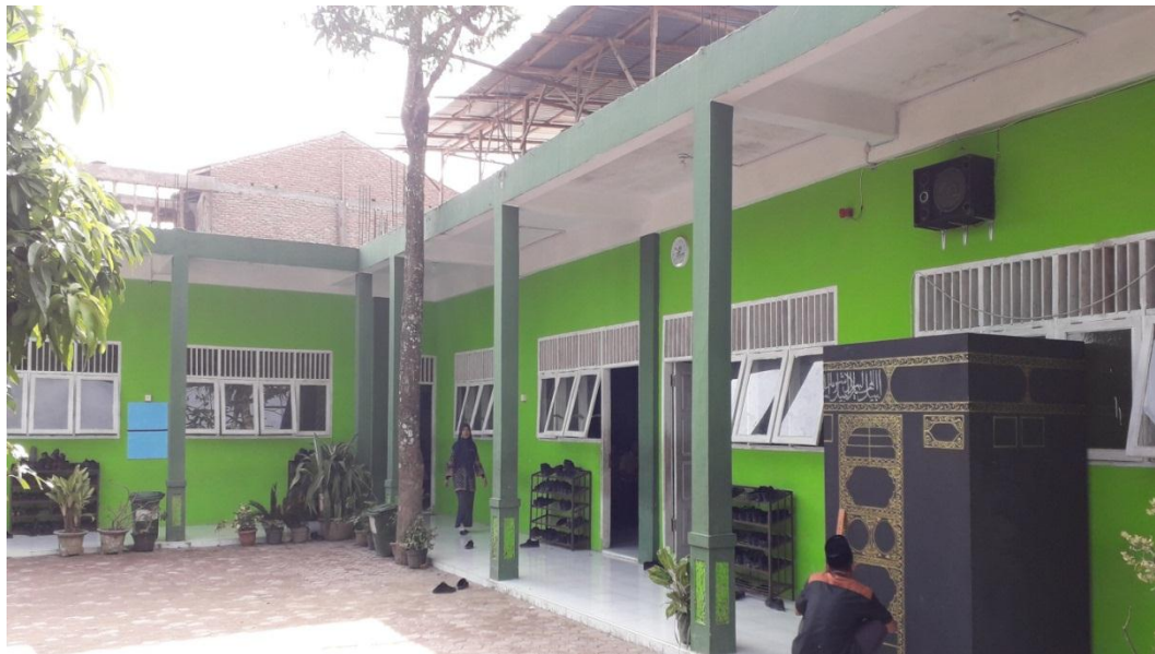
Lingkungan Depan Bangunan MTs Al-Washliyah Kolum
