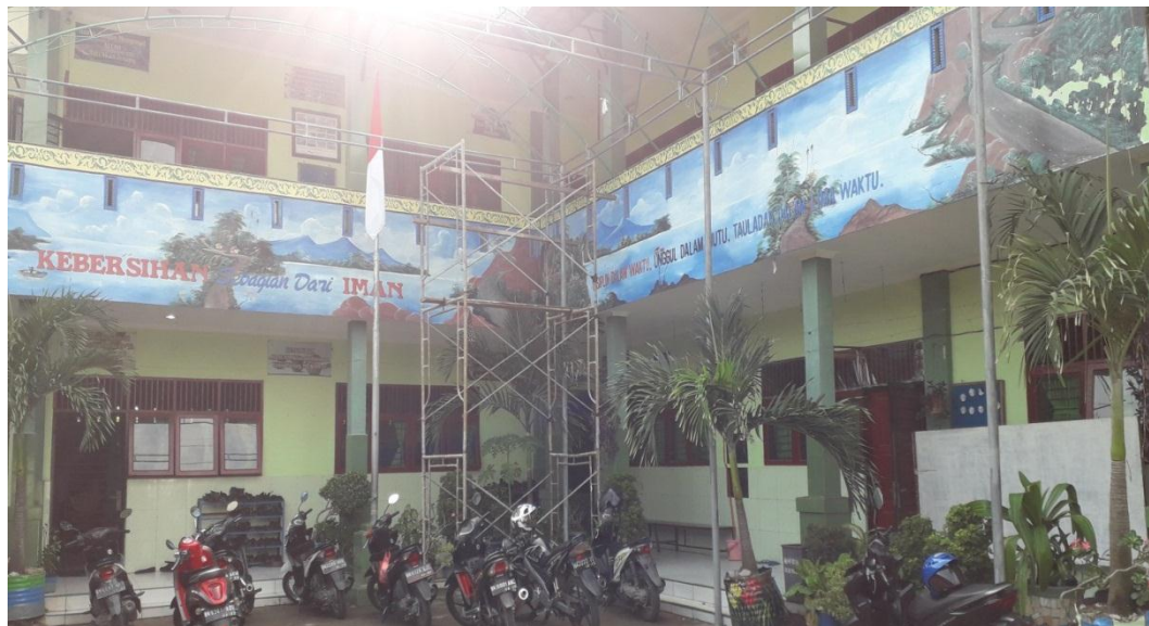
Lingkungan Depan Bangunan MTs Al-Washliyah Kolan
