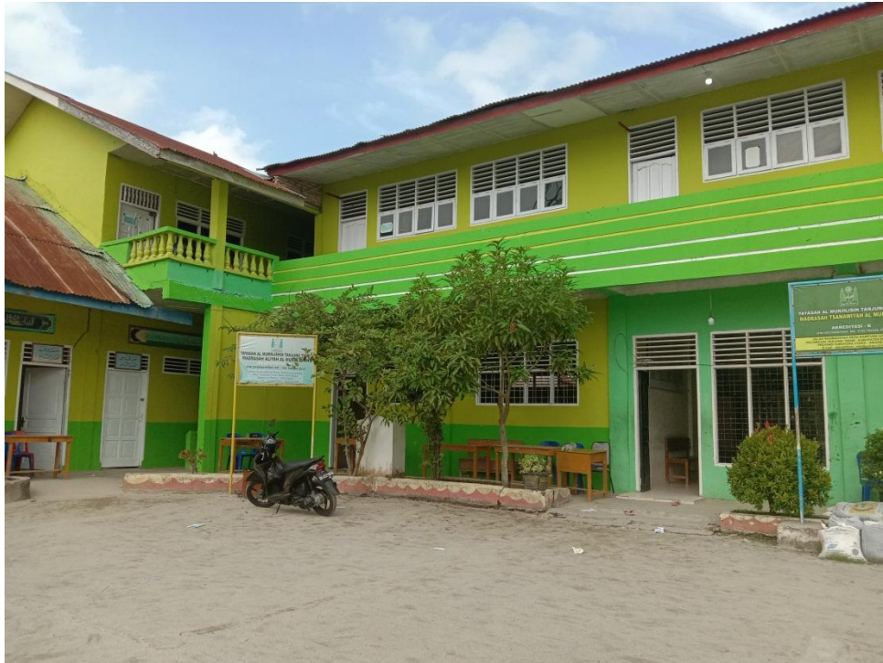
Gedung Madrasah Tampak dari Samping Kiri
