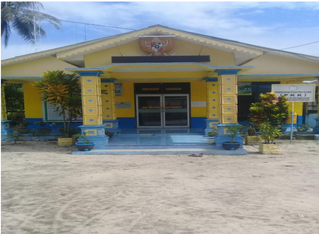
Gambar 18: Kantor kepala Desa Dahari Selebar Kecamatan Talawi Kabupaten Batu Bara
